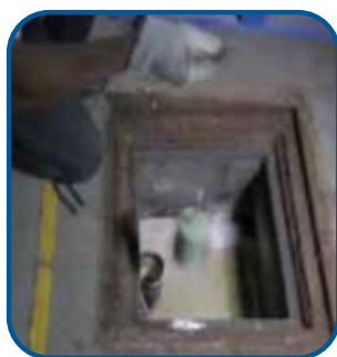
Imagen 1: NOVOMAX BLOC-2.2 es un bloque de liberación lenta que se puede colocar en las trampas de grasa para desalentar la acumulación de grasa con el tiempo.
